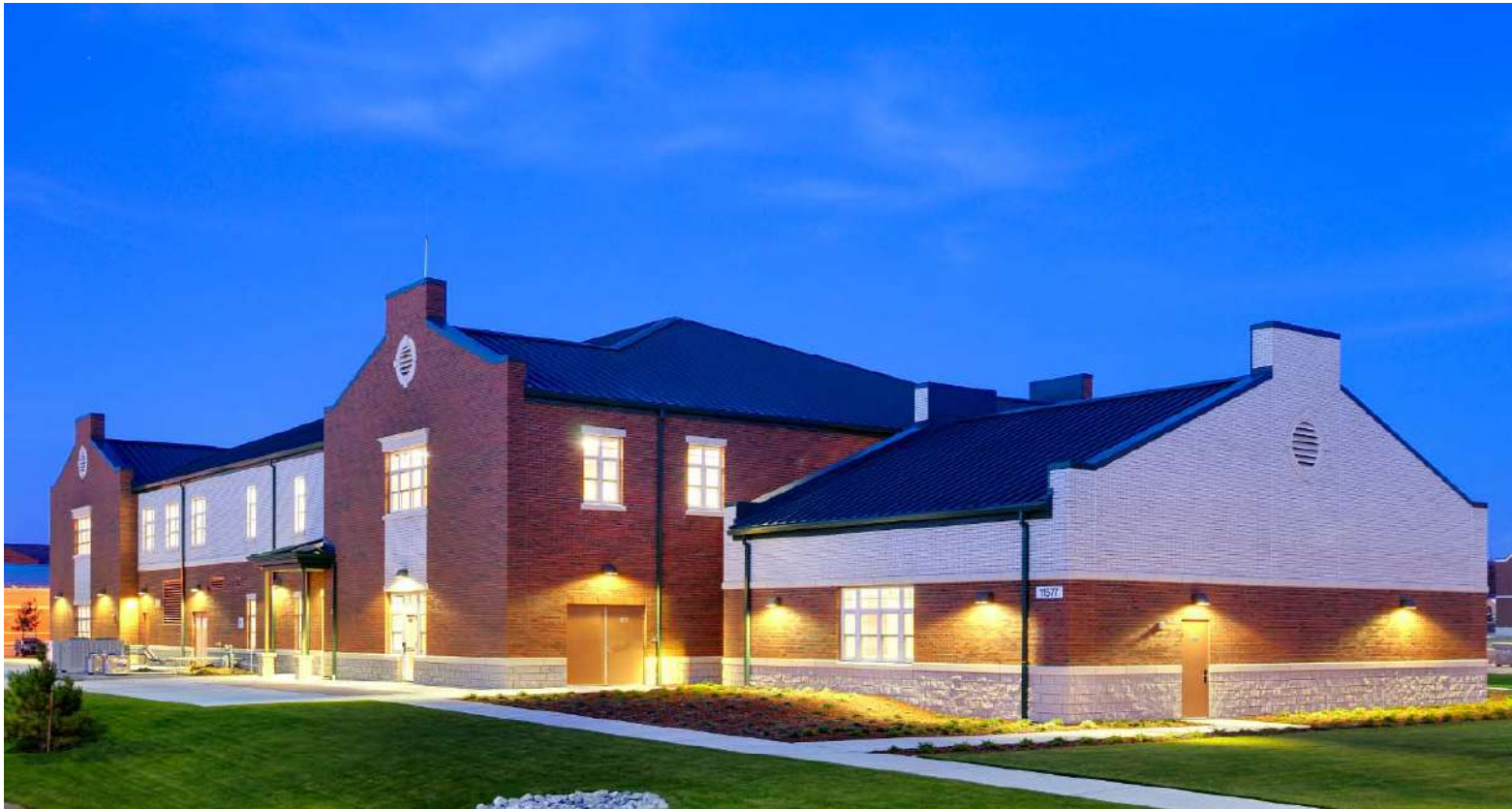
Fort Lewis, San Antonio, EEUU Arquitecto | PGA Architect StoTherm Classic
